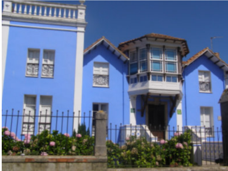
Vivienda propiedad del constructor Manuel Posada Noriega conocida como “El cantu” Fue construida en los años 20, se encuentra en Colombres Fotografía de elaboración propia.
